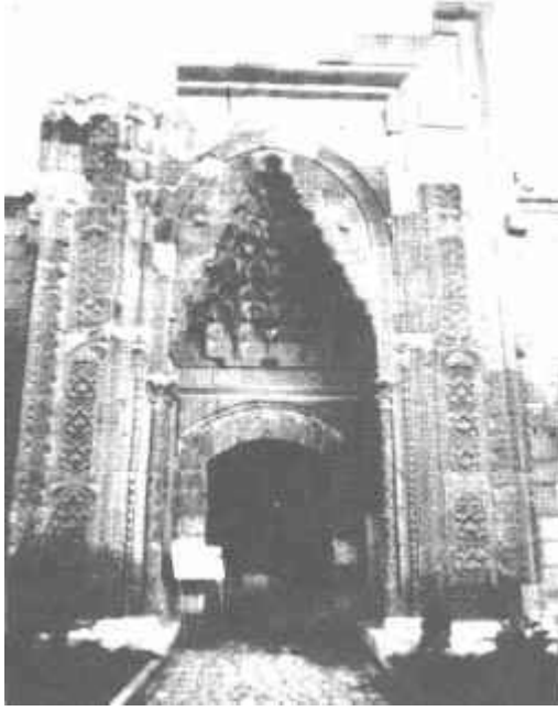
Şekil 1: Amasya Bimarhanesi'nin onarım görmüş taçkapısı
