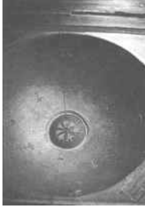
Resim: 21. Batı köşedeki odanın bağdadî kubbesi.
