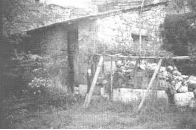
Resim: 3. Medresenin güney köşesinde bulunan dershane odası kalıntısı üzerine yapılan kulübe.
