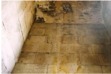
Resim 11: Haydar Bey Köşkü, güneydoğu köşedeki mekânın doğu duvarındaki künk izi.
