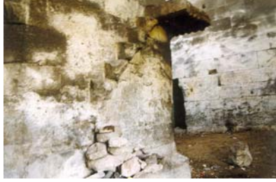
Resim 5: Haydar Bey Köşkü, merdiven (vestibülün doğu duvarındaki bölümü).
