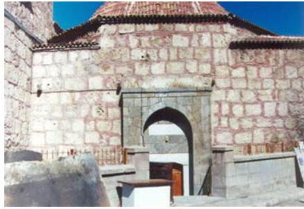
Resim 8- Eski Hamam, kadınlar kısmı güney cephe.
