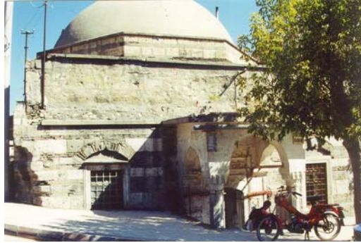
Resim 13- Yeni Hamam, erkekler kısmı batı cephesi.
