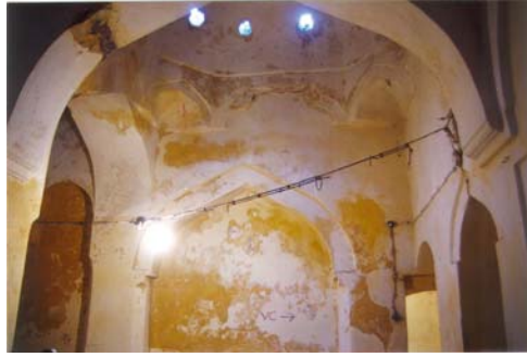
Resim 15- Yeni Hamam, erkekler kısmı ılık bölümü.
