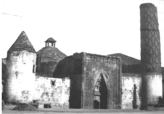
Resim 2. Erzurum Yakutiye Medresesi, batı cephe onarım öncesi (Erzurum Müzesi Arşivi).
