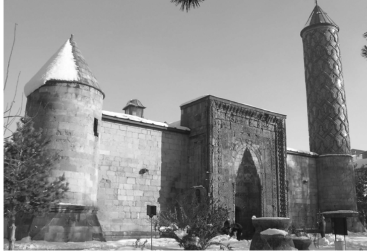
Resim 3. Erzurum Yakutiye Medresesi, batı cephe onarım sonrası.
