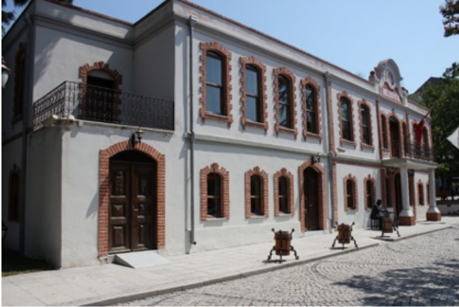
Foto. 2: Çorlu belediye binası kuzeybatı cepheye bitişik ek bina (E. Kolay)
