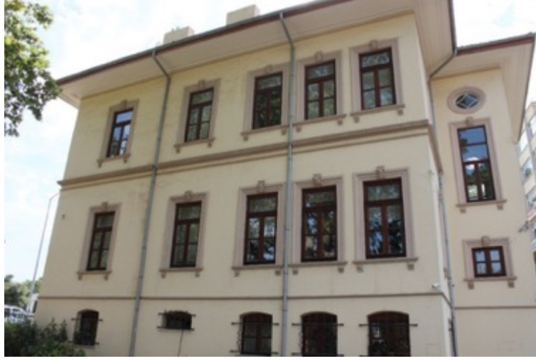
Foto. 39: Tekirdağ belediye binası doğu cephe genel görünümü (E. Kolay)
