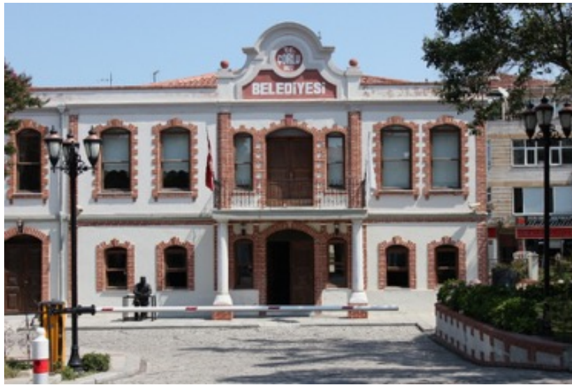
Foto. 6: Çorlu belediye binası güneybatı cephe genel görünümü (E. Kolay)
