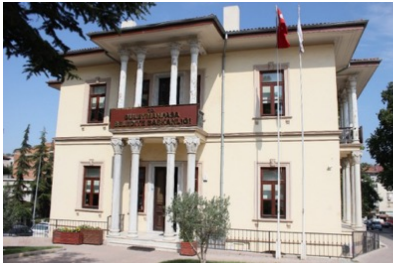
Foto. 41: Tekirdağ belediye binası batı cephe genel görünümü (E. Kolay)
