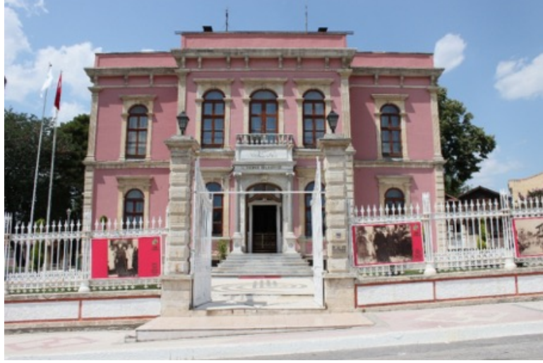
Foto. 17: Edirne belediye binası güneydoğu cephe genel görünümü (E. Kolay)
