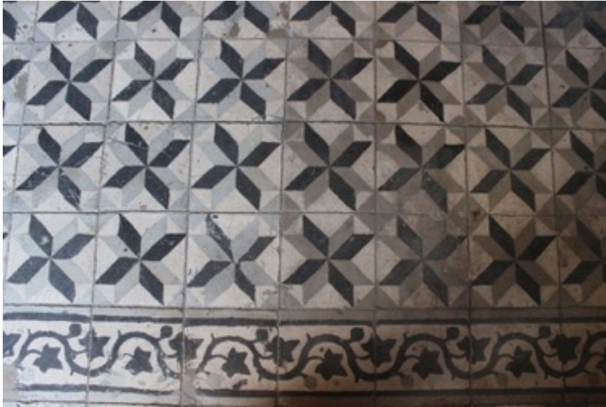
Foto. 9: Çorlu belediye binası zemin kat sofası döşemesindeki karo malzeme (E. Kolay)
