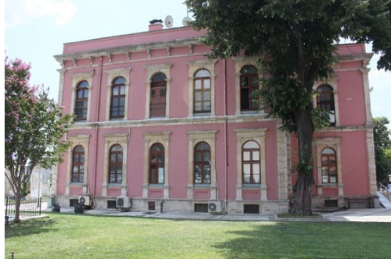
Foto. 18: Edirne belediye binası kuzeydoğu cephe genel görünümü (E. Kolay)
