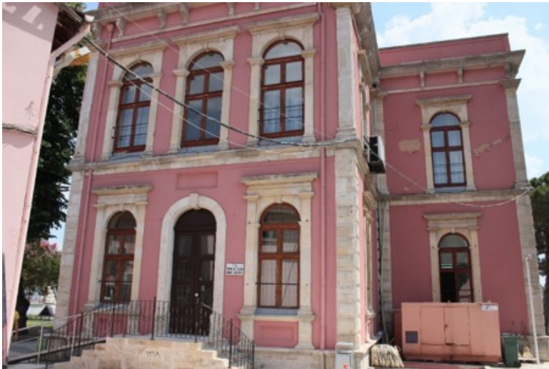
Foto. 19: Edirne belediye binası kuzeybatı cephe genel görünümü (E. Kolay)
