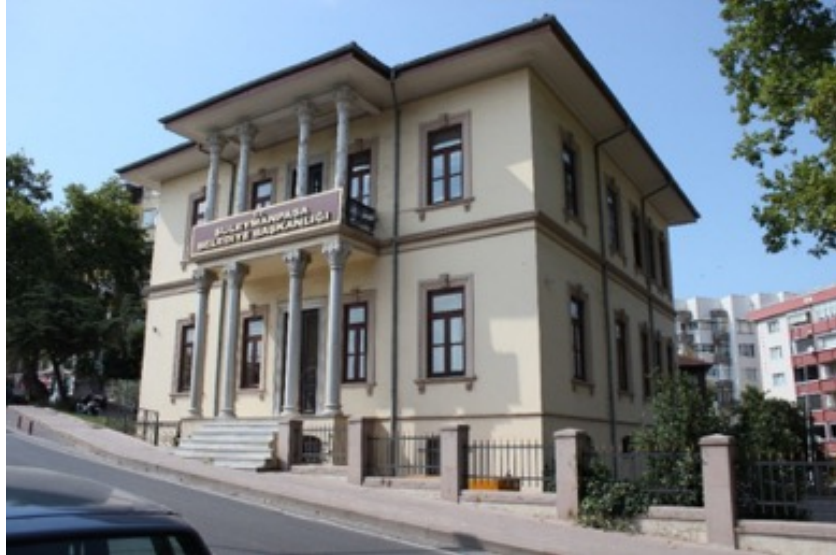
Foto. 38: Tekirdağ belediye binası güney cephe genel görünümü (E. Kolay)
