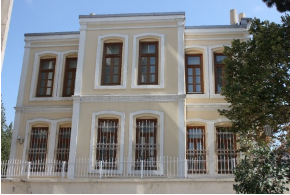
Foto. 30: Kırklareli belediye binası güney cephe genel görünümü (E. Kolay)
