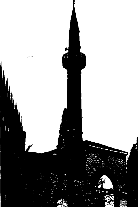
Resim 3: Bursa Muradiye Camii minaresi
