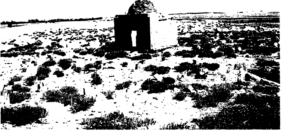
Resim 25: Altuntaş Yapılcan Köyü Türbesi
