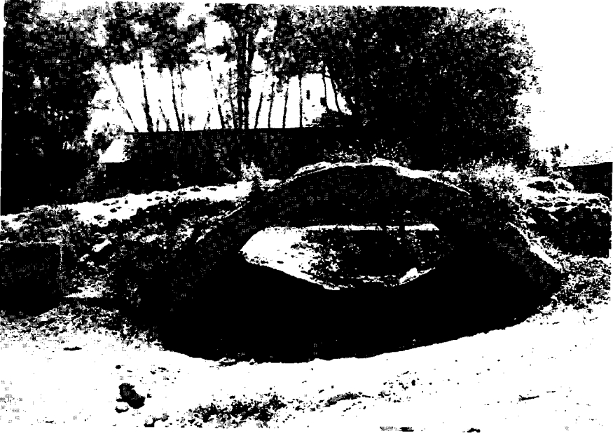
Resim 23: Altıntaş Köyü'ndeki köprü
