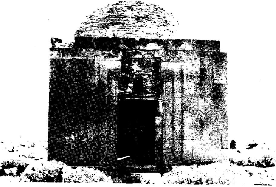
Resim 27: Yapılcın Köyü Türbesi, kuzey cephesi
