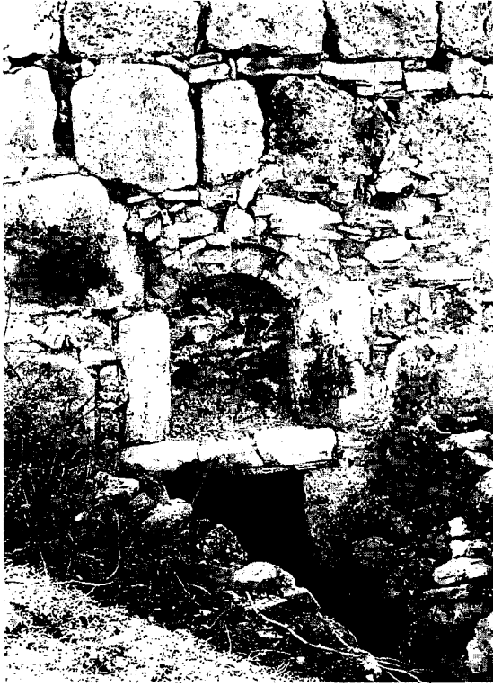
Resim 17: Şeyh Yahşi Köyü Türbesi, kapı
