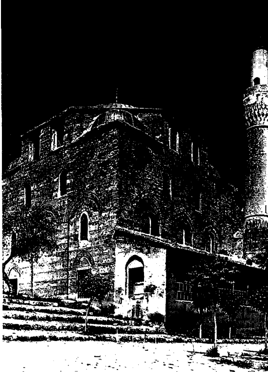
Resim 6: Halime Hatun Camii, kuzeydoğu cephe (1942 Ankara Vakıflar Genel Müdürlüğü Arşivin'den)
