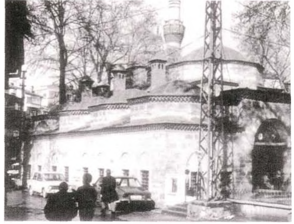
Resim 10: İshak Paşa Medresesi batı cephe
