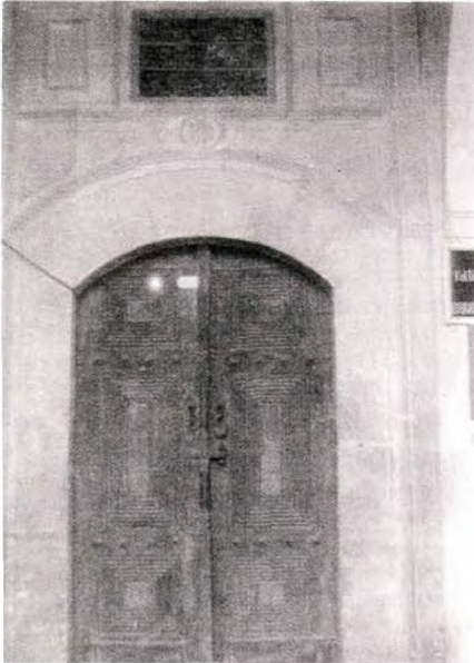
Resim 12: İshak Paşa Medresesi "Dershane'ye" geçilen kapı
