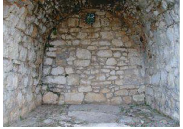
Resim 26: 10 No.lu mezar yapısının tonozlu üst mekan görünüşü
