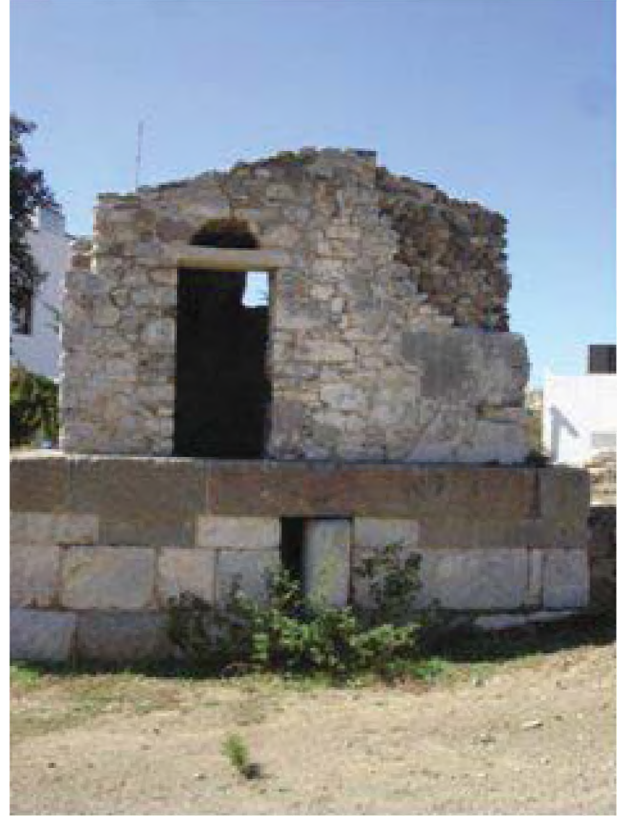
Resim 29: 12 No.lu mezar yapısının dıştan görünüşü
