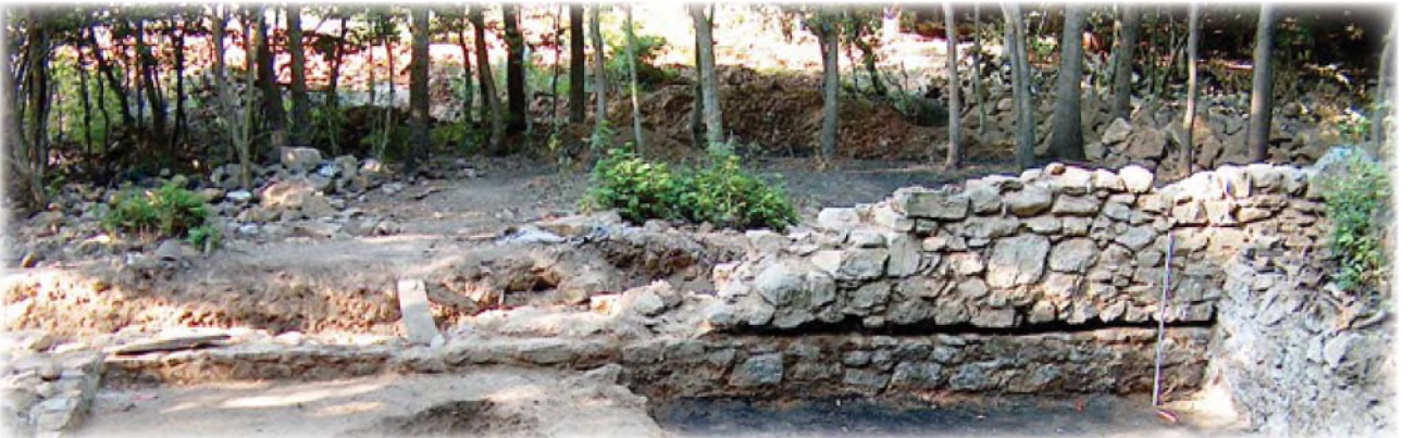
Resim 2: Duvar 53'ün kuzeyden görünümü. Hatlı boşlukları belirgindir. Ayrıca bu fotoğraf duvarın farklı yüksekliklerde korunduğunu göstermektedir
