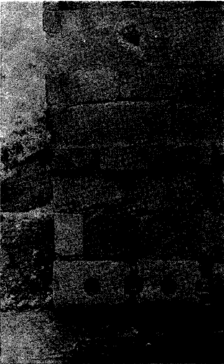
Res. 7 — Aynı köprü'nün orta ayağından ayrıntılı bir görünüş (Yapı taşı olarak yazıtlı bir mezar taşı kullanılmıştır).
