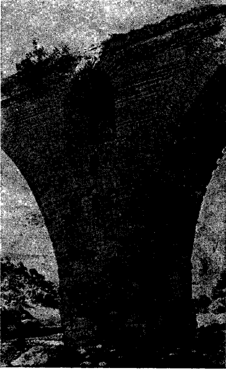
Res. 5 — Aynı Köprü'nün ayaklarından biri (Geç Antik Çağ ve Bizans devri malzemesinden faydalanılarak inşa edilmiştir).
