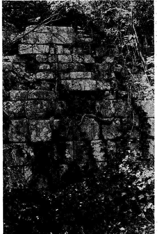
Res. 5 — Derviş kapı kuzeyinde içyüz.
