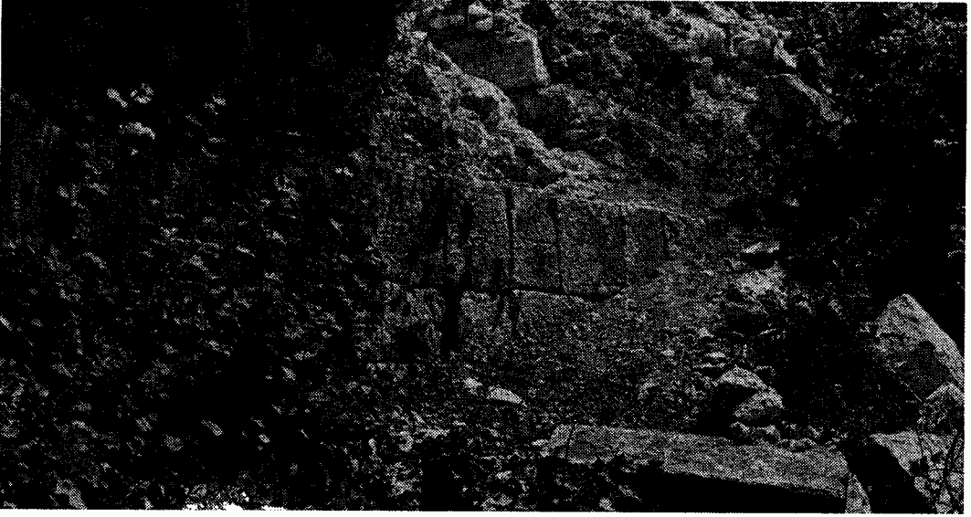
Res. 6 — Derviş kapı kuzeyinde dış yüz.
