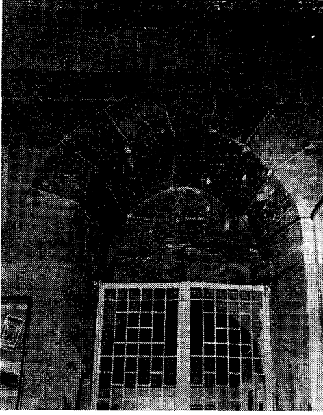
Res. 19 — Konya - İnce Minareli Medresenin giriş holündeki içe geçen kapı.
