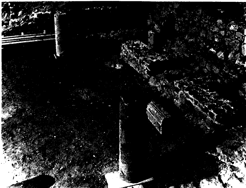
Abb.: 21 — Hestiaion. Nordbereich des Saales
