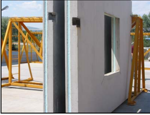
Resim 6. Arasında ısı yalıtımı katmanı bulunan sandviç paneller.
