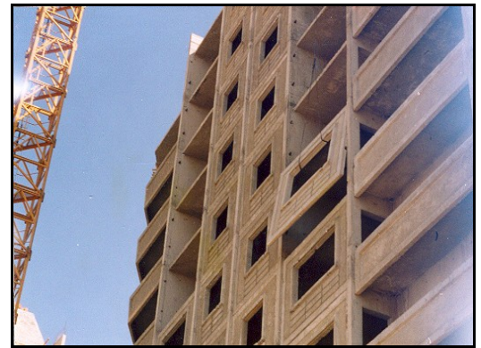
Resim 5. Prekast cephe panelinin vinç vasıtasıyla yerine taşınması.
