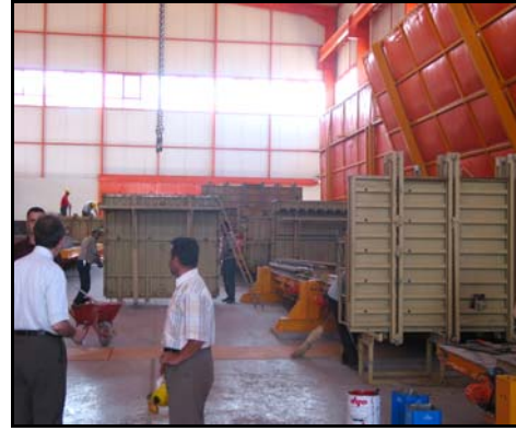
Resim 1. Prekast yapı elemanı üretim yeri.
