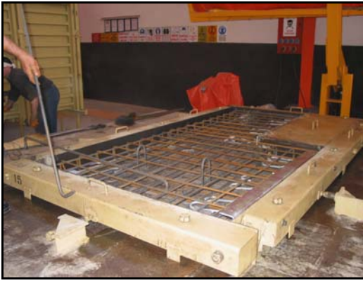
Resim 9. Prekast atölyesinde sahanlık üretiminin gerçekleştirilmesi.
