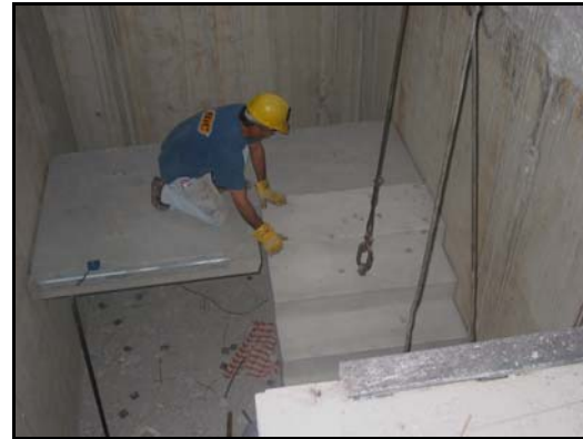
Resim 8. Prekast merdivenin yerine montajının gerçekleştirilmesi.
