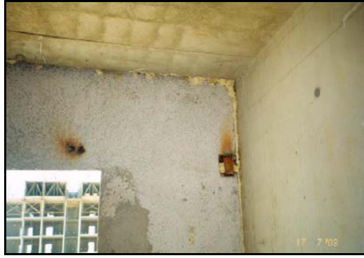
Resim 13. Prekast cephe elemanı ile duvar arası boşluğun içeriden izolasyonu.
