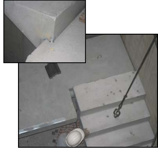
Resim 16. Prekast merdivenin ara sahanlık üzerine bindirilerek montajı.
