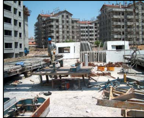
Resim 2. Şantiyede kurulan prekast eleman döküm atölyesi.
