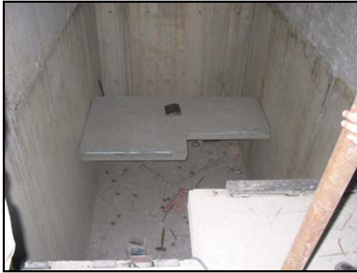
Resim 10. Prefabriğe olarak üretilen ara sahanlığın yerinde montajı.
