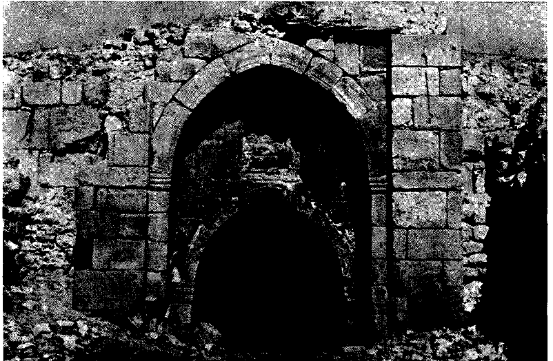
Res. 3 — Konya-Altınapa Kervansarayı kışlık girişindeki tak kapısı.
