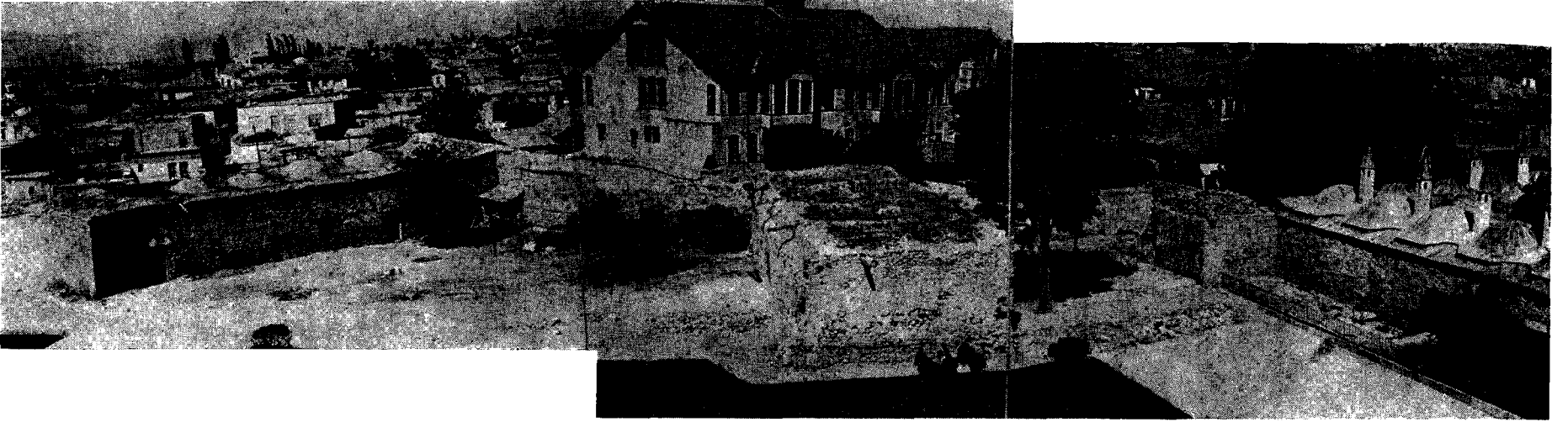
Res. 8 — Konya - II. Selim Mimari Külliyesinde ve Menzilhane'nin genel görünüşü (1956)
