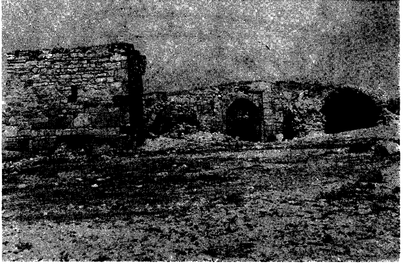
Res. 1 — Konya-Altınapa Kervansarayı giriş kısmı görünüşü.
