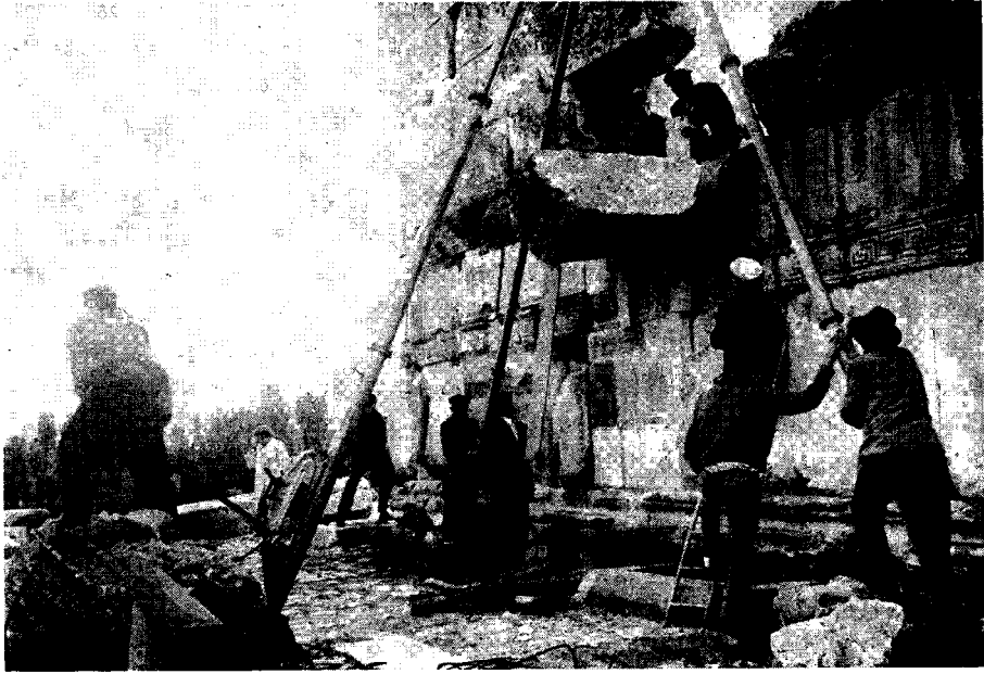
Abb. 1. Aezani, Zeustempel. Versetzen eines Gesimsblockes der Zellamauer.
