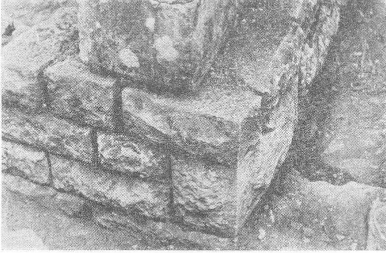
Res. 4 — Kaunos Stoa'nın doğu-kuzey köşesi, dıştan.
