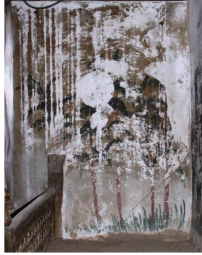
Fot. 41: Güney duvarın batı köşesi
