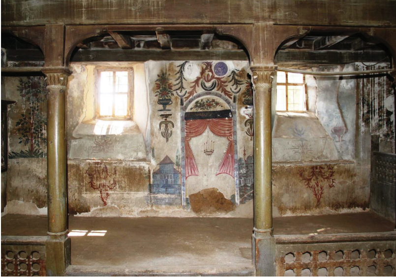
Fot. 34: Güney duvar genel görünümü
