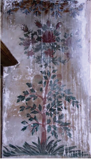
Fot. 40: Güney duvarın kuzey köşesi
