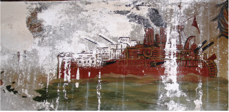
Fot. 26: Kuzey duvar panolar ile tavan arasındaki bölüm
