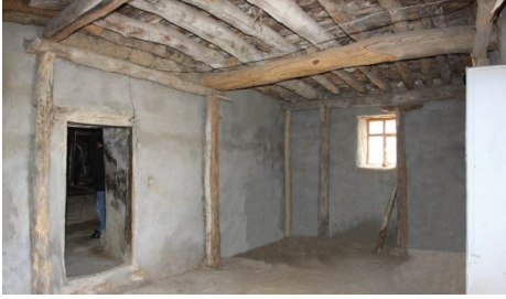
Fot. 7: Yapının 2015 yılı öncesi durumu, aralık bölümü
