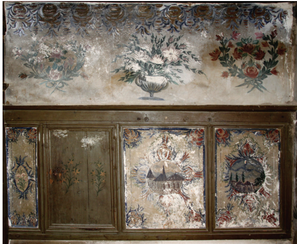
Fot. 33: Doğu duvar, güney nimseki bölümü
