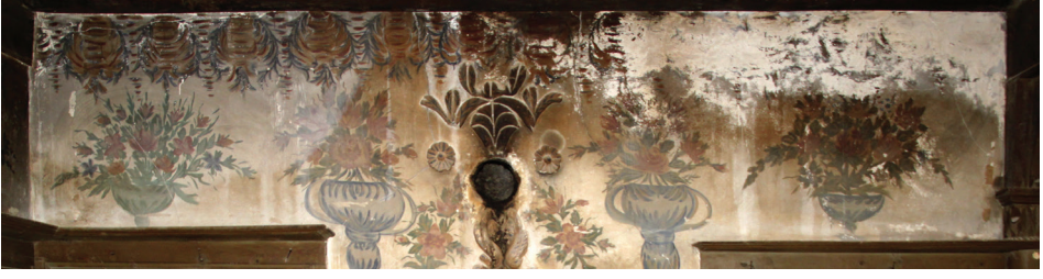
Fot. 32: Doğu duvar, kuzey kısımda sergen ile tavan kirişleri arasındaki duvar yüzeyi
