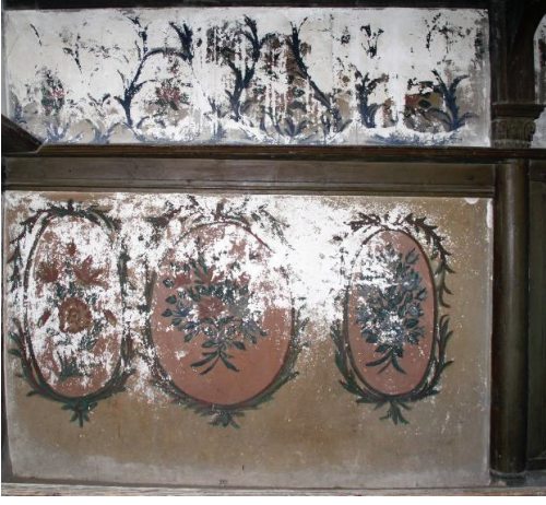
Fot. 18: Kuzey duvar batı kısım
