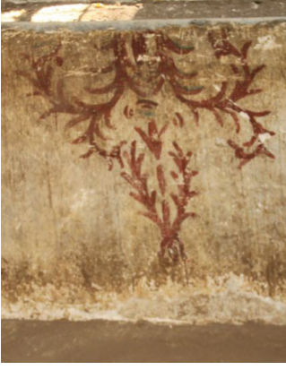
Fot. 37: Güney duvar pencereleri iç alt yüzü
