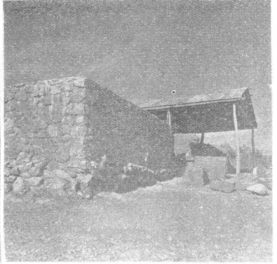
Res: 3 — Aynı burç duvarının restorasyondan sonraki hali
