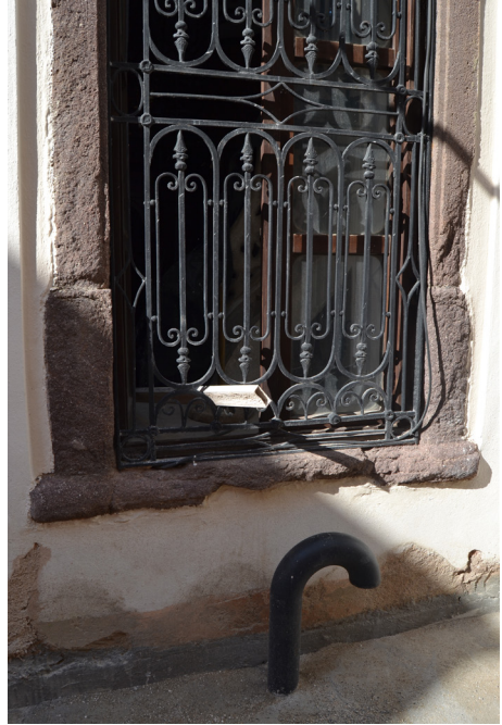
Fotoğraf 34: Onarım sırasında uygulanan drenaj sistemi.
