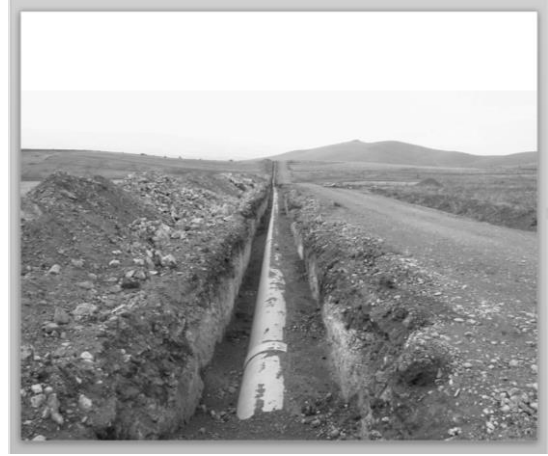
Şekil 28. Proje sahasında yapılan çalışmalar
