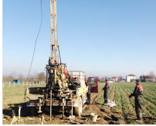
Şekil 3. Araziye SPT deneyine ait sondaj çalışması.
