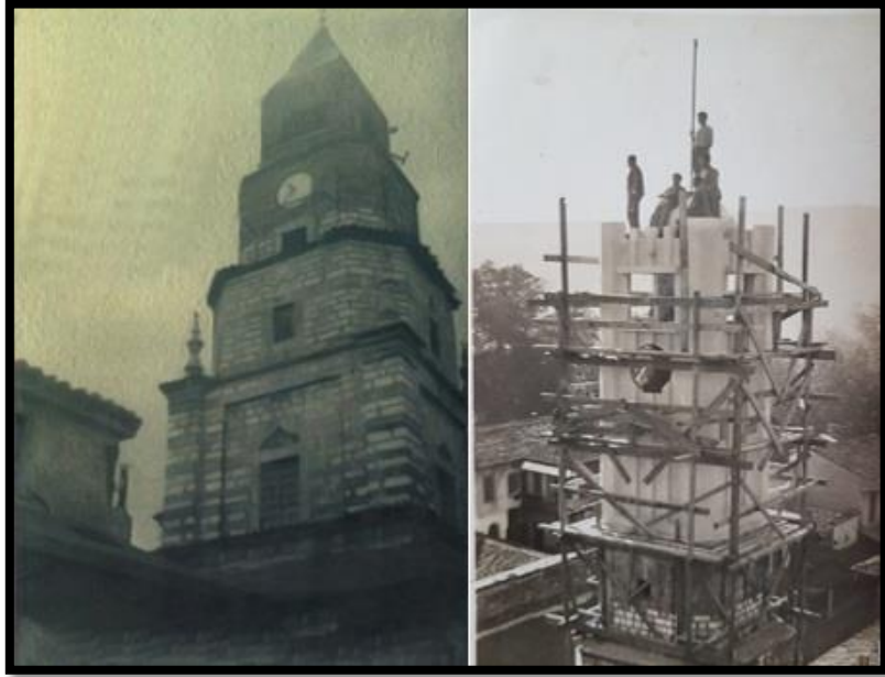
Şekil 8. (sol) Saatli Kulenin bulunabilen en eski resim 1950 öncesi (Aladağ, 2016, Kapak), (sağ) Betonarme son kademenin inşaatı †††
