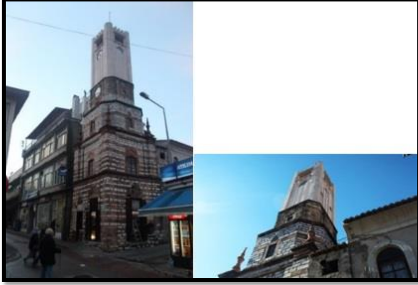
Şekil 9. (sol) Güneydoğu cephesi, (sağ) Kuzeydoğu cephesi
