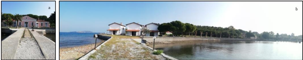
Şekil 30 - (a) Tephirhane yapısı ve depo yapıları (b) önünde yer alan iskeleler (2019).
