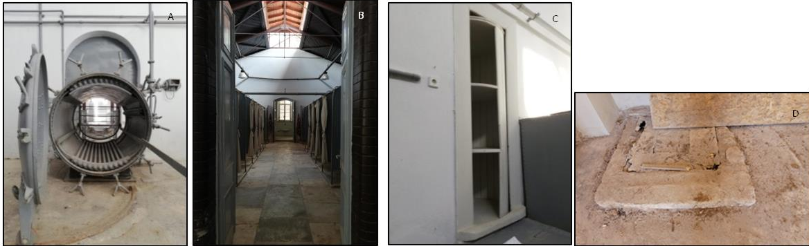
Şekil 43 - Tephirhane yapısına ait a) etüv makinaları b) banyolar c) hareketli dolaplar d) beton kaide izi (2019).
