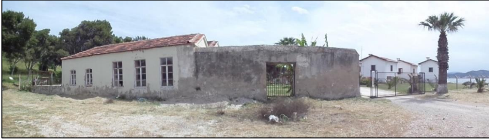
Şekil 27 - Küçük tephirhane yapısı ve yapıya bitişik duvar kalıntısı (2019).
