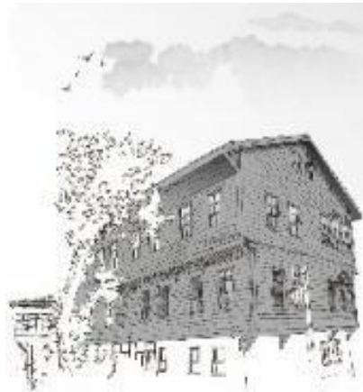
Şekil 45. Kuzeybatı Yönünden Rüştüye Mektebi'nin illüstrasyonu (Özbursalı, 2018)
