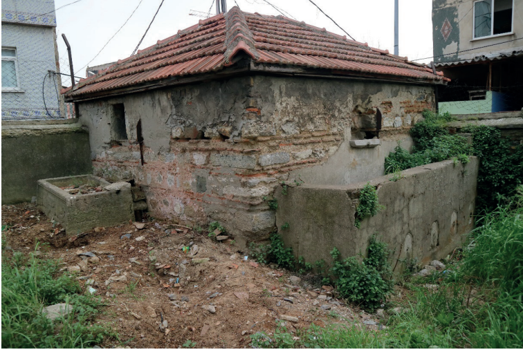
F. 17: Salih Ağa Çeşmesi kuzey cephesi (Tunçez, 2018)
