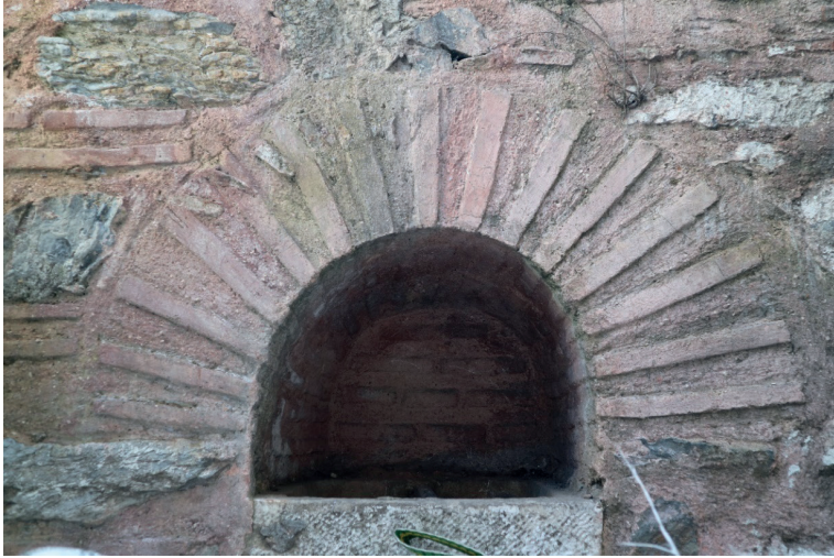
F. 40: II. Mahmut Çeşmesi (Karnavola Çeşmesi) kuzeybatı cephesindeki nişi (Tunçez, 2018)
