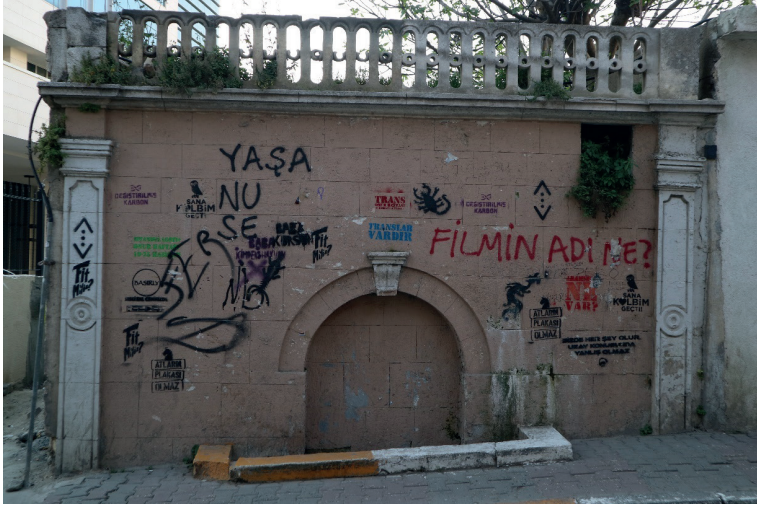
F. 8: Paşa Baba eşmesi'nin güneydoğu cephesi (Tunez, 2018)
