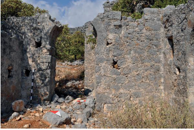
Resim 16: Sura Vadi Kilisesi Şapeli, kuzey duvarı, giriş kapısı ve kapatılmış pencere
