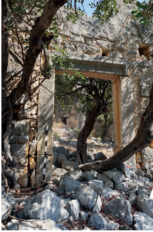
Resim 10: Sura Vadi Kilisesi, narteks dođu duvarı, orta nef giriř kapısı, hatıl yuvaları ve kat/üst örtü ayırımı
