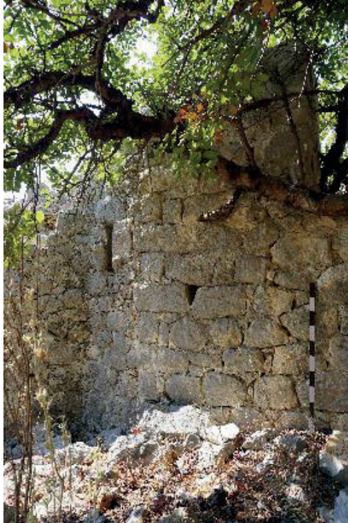
Resim 17: Sura Vadi Kilisesi (sağda) ve Şapeli (solda) doğu cepheleri, duvar örgüsü farklılığı, kuzeydoğudan görünüm
