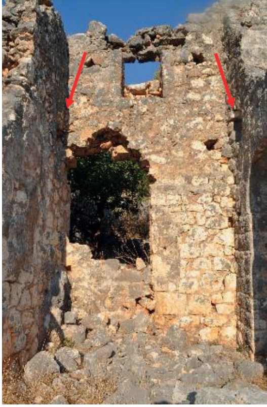
Resim 14: Sura Vadi Kilisesi, kuzey nef dođu duvarı, batıdan görünüm, kuzey duvar ve duvar payesi yan yüzeyinde bulunan hatıl yuvaları
