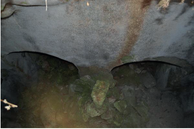
Resim 3: Sura (Soura) Şehir Kilisesi, 1 Numaralı Kilise, Sarnıç, kuzeyden görünüm
