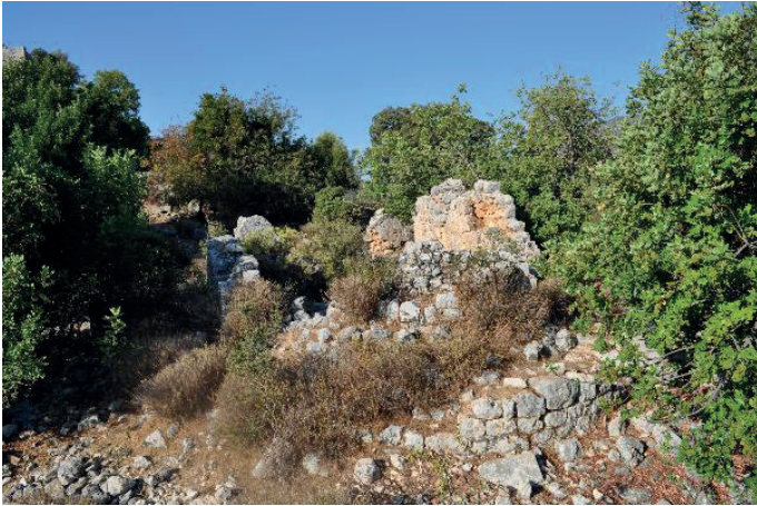
Resim 6: Sura Şehir Kilisesi, 3 Numaralı Kilise/Şapel apsisi, doğudan görünüm
