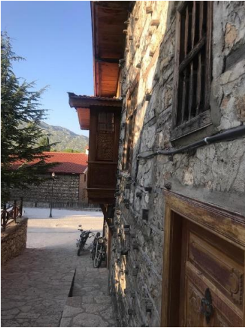
Görsel 2. Kuru Duvar Tekniği ile İnşa Edilen Düğmeli Ev Örneği (Ormana Mahallesi-İbradı, 29. 08.2021)
