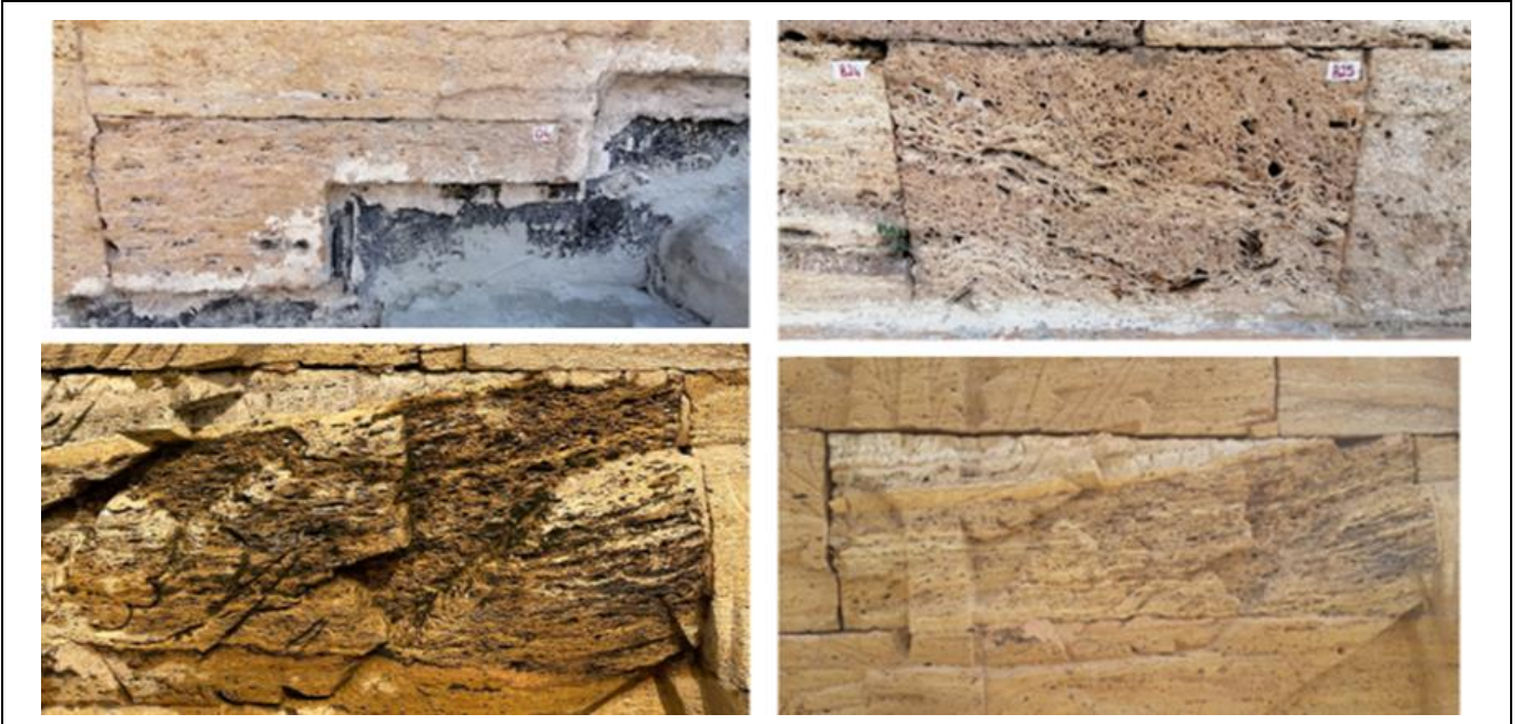
Resim 7. Taş Yüzeylerdeki Erozyon, Aşınma ve Yapraklaşma (Fotoğraf: O. Ekinci)
