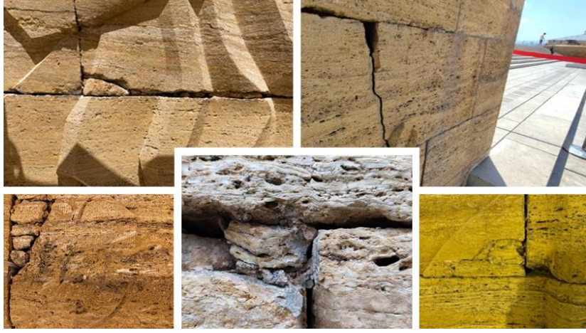
Resim 8. Taş Yüzeylerdeki Derz Kayıpları ve Ayrılmalar (Fotoğraf: M. Cura)
