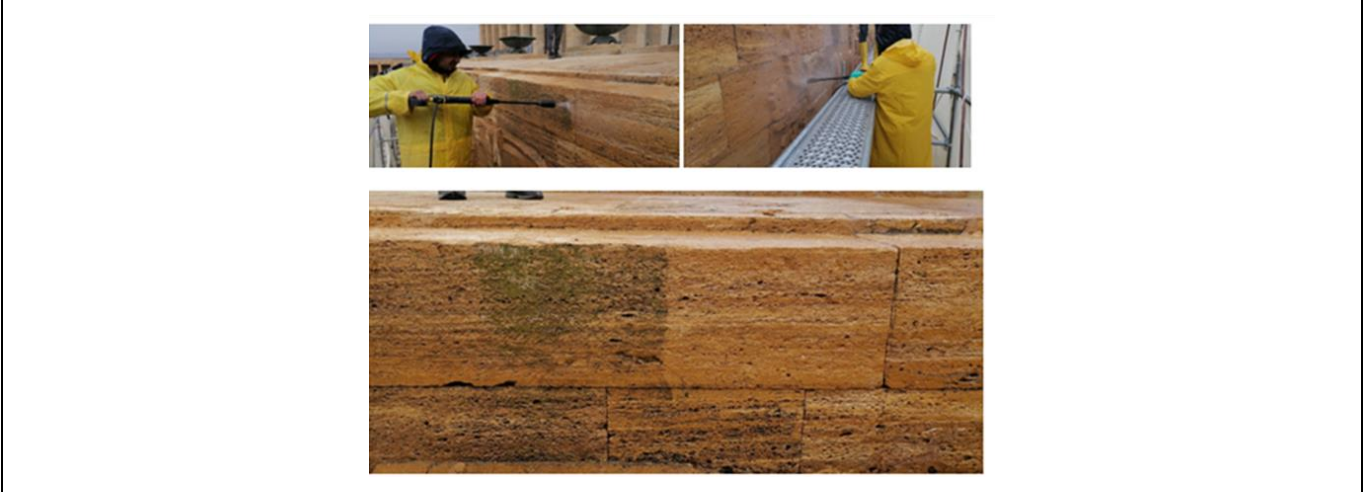
Resim 12. Taş Yüzeylerde Gözlenen Mikrobiyolojik Oluşumların Atomize Suyla Temizliği ve Drenajı (Fotoğraf:Y. Sayın)
