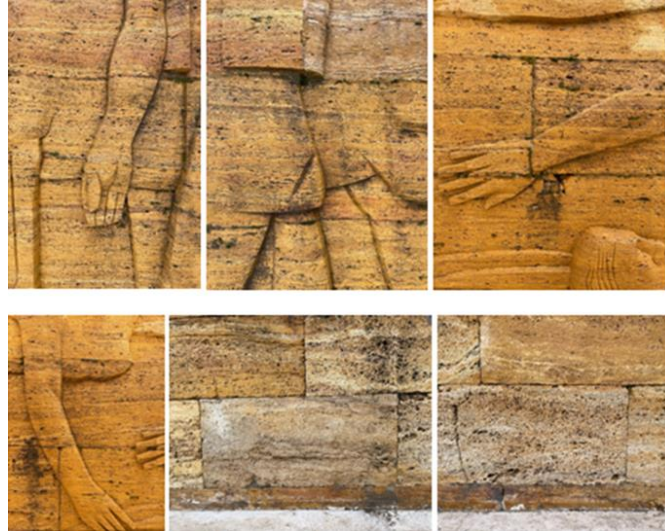
Resim 6. Taş Yüzeylerdeki Siyah Kabuk Oluşumları (Fotoğraf: M.Cura)
