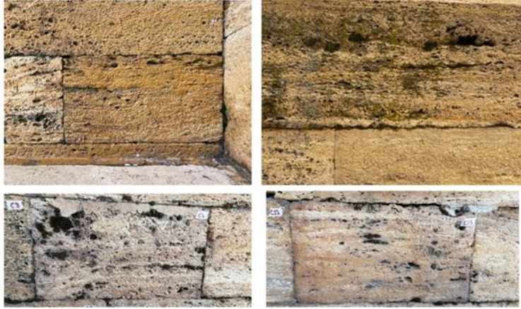
Resim 9. Taş Yüzeylerdeki Mikrobiyolojik Oluşumlar (Fotoğraf:Y. Sayın)
