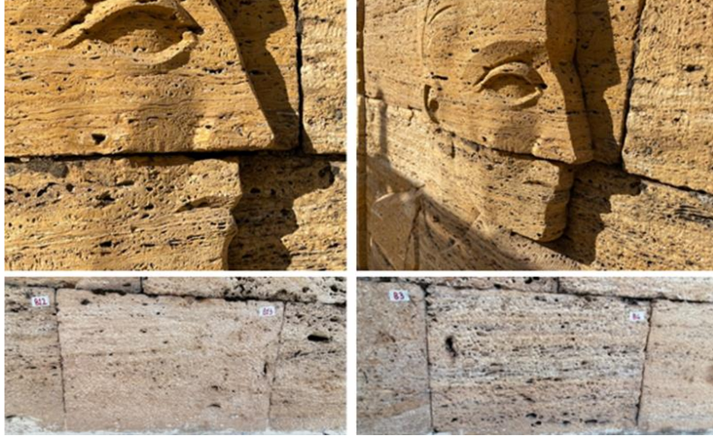
Resim 5. Yapının Taş Malzemesinde Görülen Petek Gözlülük (Fotoğraf: E. Kök )
