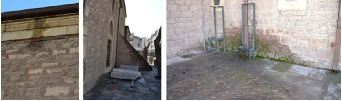
Fotoğraf 18-19-20: Yağmur sularının yapıya etkileri
