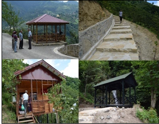
Fotoğraf 17. Tabiat parkında yapılan kamelyalar, merdivenler ve seyir teraslarından görüntümler.
