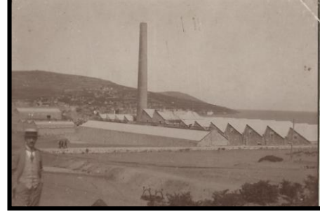
Foto 10: Fabrikanın inşaatının tamamlanmış haliyle görünümü (Z. Z. Özcanoğlu Arşivi).
