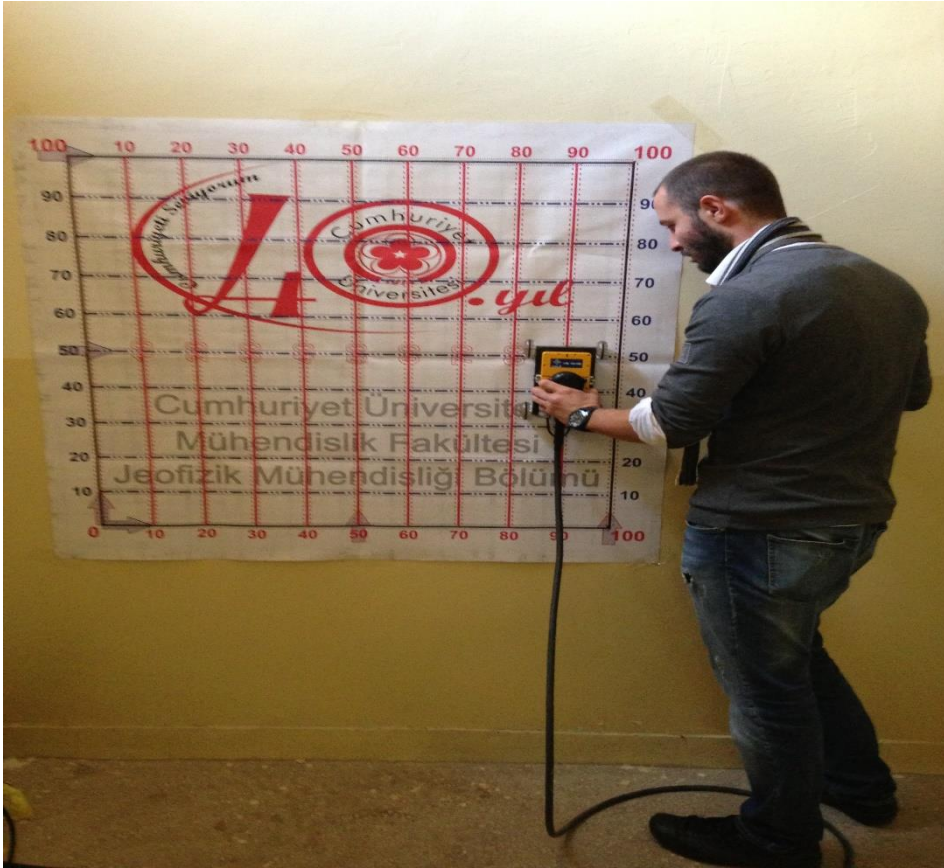
Şekil 4. Mühendislik Fakültesi B binası Perde duvar üzerinde ölçü alımı gösterimi
