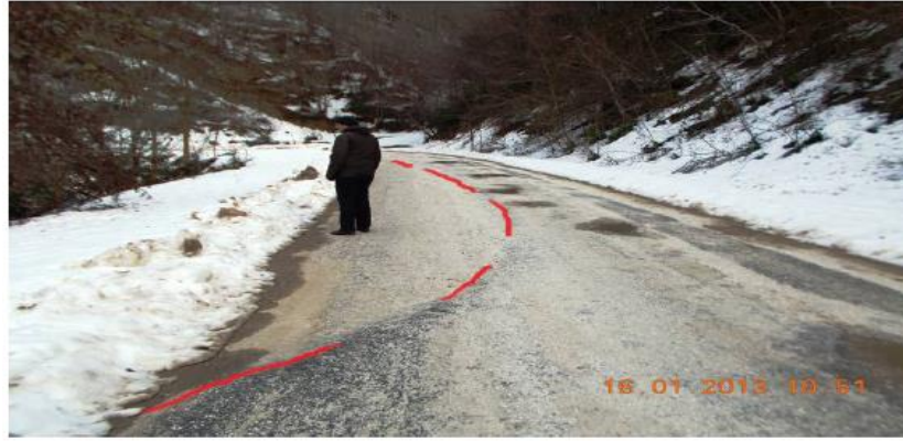
Şekil 6. Heyelanın yol üzerindeki muhtemel sınırları
