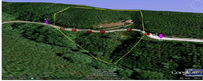
Şekil 3. Uydu Görüntüsü Üzerinde Arazi Çalışmalarının Aplikasyonu (Toprak Kayması İle İlgili Uydu Görüntüsü)
