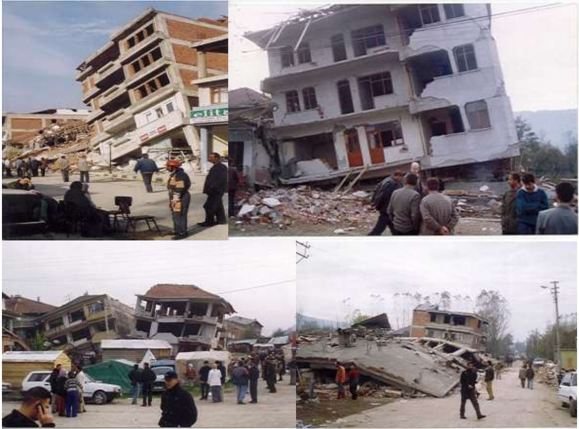
Şekil 9. Yapı zemin rezonans uyumuna göre oluşan Düzce kent merkezinde yapı hasarları [1]
