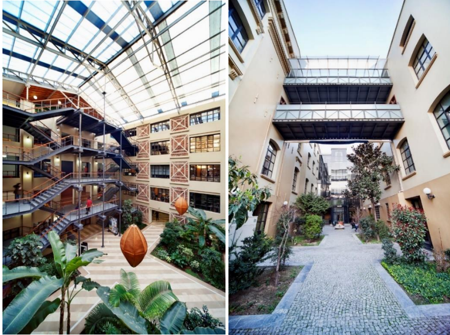
Şekil 6. a) Eski kullanımında H blok olan yapıya yapılan iç avlu b) Eski kullanımında A ve C blok arasında bulunan köprü (URL-3)
