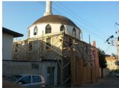
b. Güney cephe
