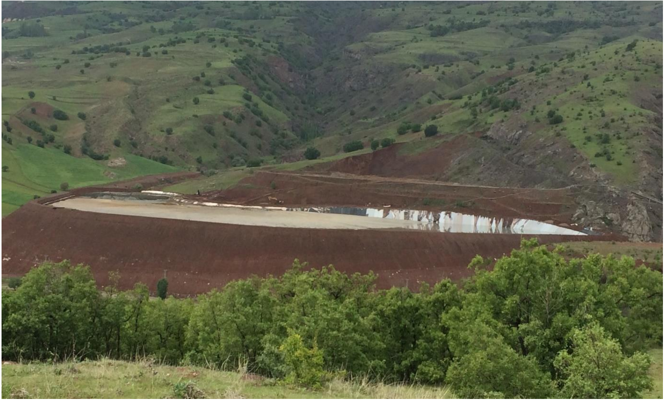
Şekil 2. İşletme ömrünü tamamlamış atık barajı
