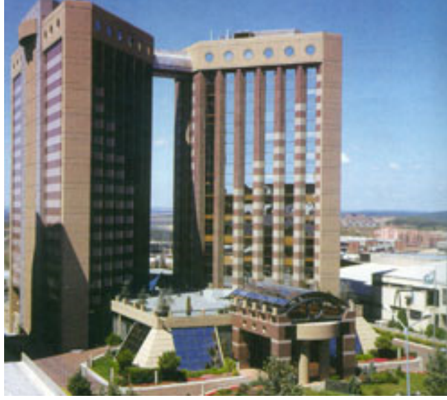
Şekil 3.13. Garanti Bankası Merkez Binası, Arolat Mimarlık, 1993 [56].
