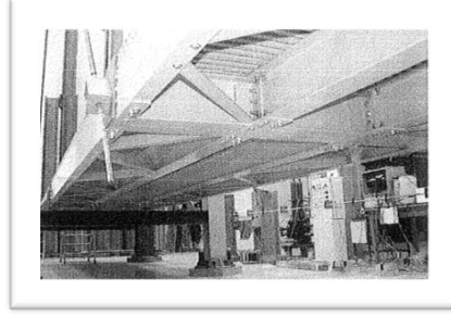
Şekil 1. FRP kompozit malzemeli yaya köprüsü
