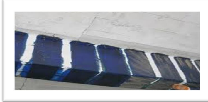
Şekil 7. Kirişin tekstil malzemesi ile desteklenmesi
