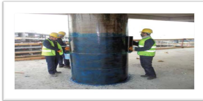
Şekil 8. Kolonun lif takviyeli bir kompozit malzeme ile desteklenmesi
