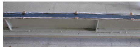
Şekil 1. Çelik kirişe HM-CFRP yapıştırılması (Bonding steel beams HM-CFRP)
