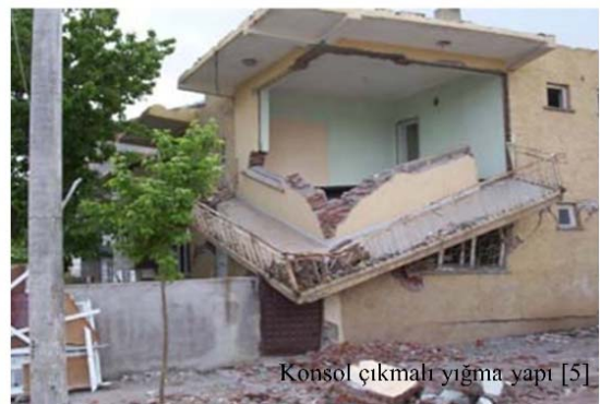
Şekil 1. Çeşitli depremlerde hasar gören bazı yığma yapılar (Some masonry structures damaged in various earthquakes)
