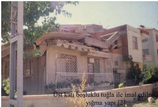
Şekil 1. Çeşitli depremlerde hasar gören bazı yığma yapılar (Some masonry structures damaged in various earthquakes)
