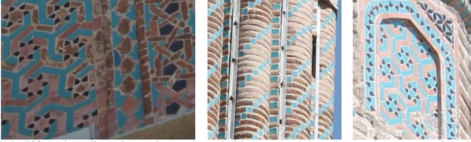
Foto. 14: Çifte Minareli Medrese, doğu minare kaide pano tuğlalarında uygulanan tamamlamalar (Solda).
