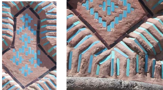
Foto. 21: Yakutiye Medresesi, minare gövde alçak zemin tuğlalarında uygulanan renklendirilmiş alçı ve kireç katkılı harç ile yapılan tamamlamalar (Solda).
