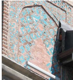
Foto. 18: Çifte Minareli Medrese, batı minare kaidesinin batı panosu çinilerinde uygulanan tamamlamalar.
