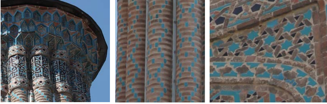
Foto. 9: Çifte Minareli Medrese, doğu minare şerefe altı kuşağında ve mukarnas çinilerinde uygulanan tamamlamalar (Solda).
