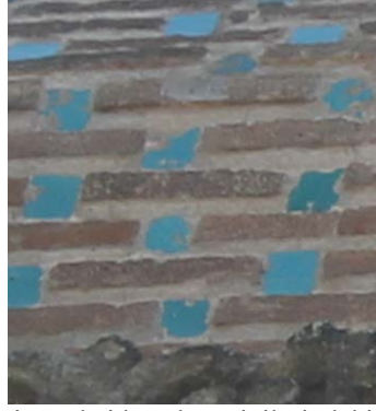
Foto. 23: Çifte Minareli Medrese, batı minare kaide pabuç çinilerindeki kenar-köşe kayıplarında uygulanan harç ile tamamlama.
