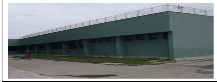
Şekil 2. Balıkesir Üniversitesi Rektörlük Matbaa Binası (Ek Bina) Resmi
