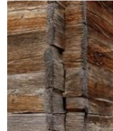
Foto. 53-54. Güney cephede karaboğaz ve kurtboğazı geçmeli duvar ayrıntıları
