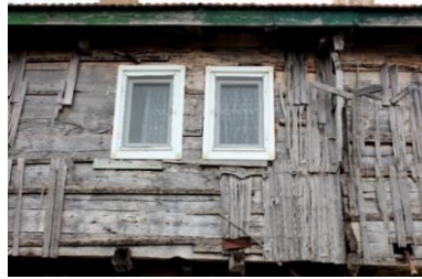
Foto. 74-75. Kuzey cephe 1. kat ayrıntıları
