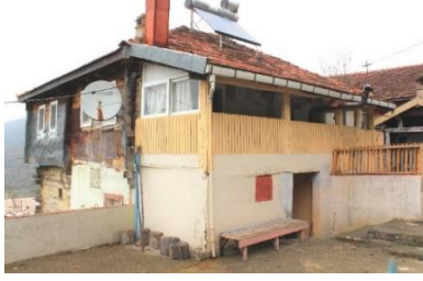
Foto. 67. 4 numaralı ev güneybatı-dan görünüm
