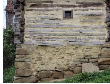
Foto. 71. Batı cephe subasman ve zemin kat ayrıntısı
