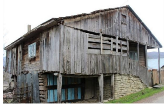
Foto. 100. Ev 9 ön ve yan cephe
