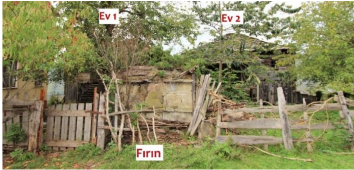
Foto. 3. 1 ve 2 numaralı evlerin ön cepheden görünümü
