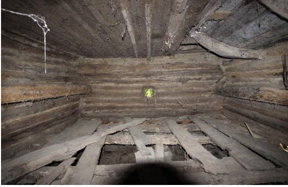
Foto. 11. 1 numaralı evin zemin kat doğu ahır iç görünümü
