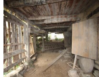
Foto. 41. Zemin kat ev altı bölümüne doğudan bakış
