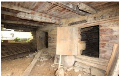
Foto. 42. 2 numaralı ev zemin kat ev altı bölümü
