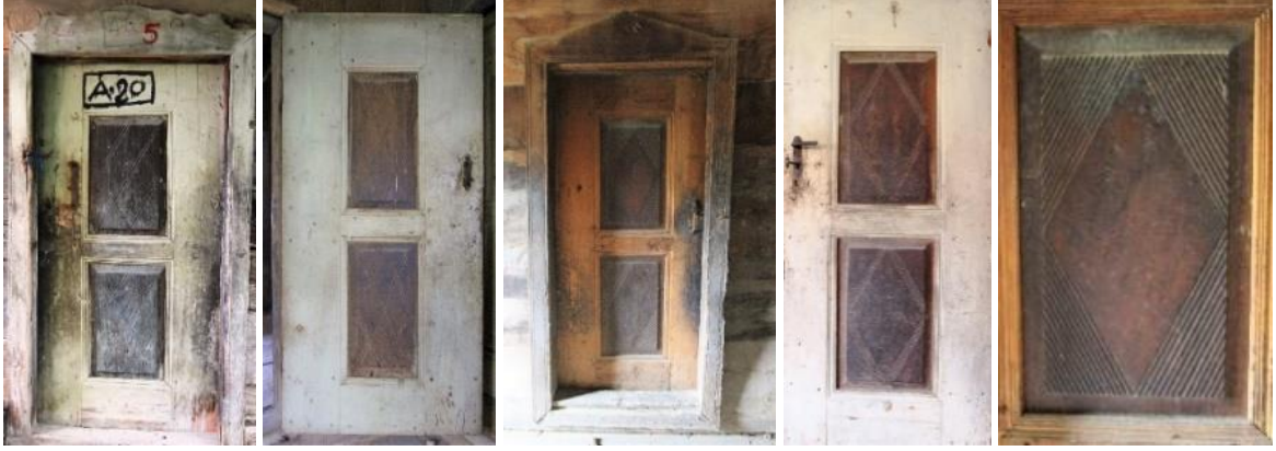
Foto. 29-33. 1 numaralı ev 1. kat giriş kapı kanadı (sol başta) ve oda kapı kanatları (ortadaki üçü) ve oda kapı kanadı ayrıntısı
