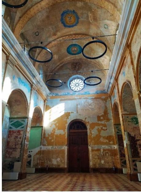
Şekil 16. Kendirli Kilisesi (Korkmaz, 2021)
