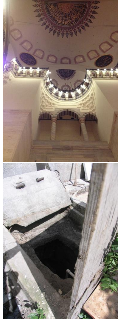
Şekil 9. Süleymaniye Camii is odası delikleri (üstte) ve yer altı kanallarına giriş sağlayan arka bahçedeki kapak (altta).
